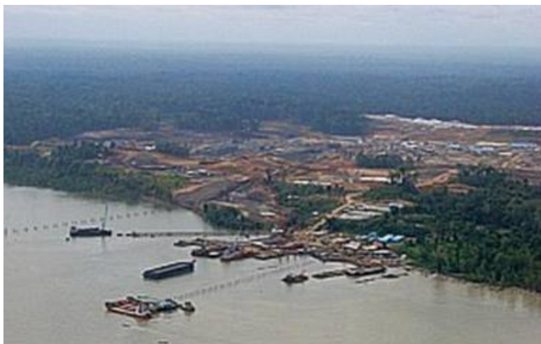
Tangguh LNG facility under construction
