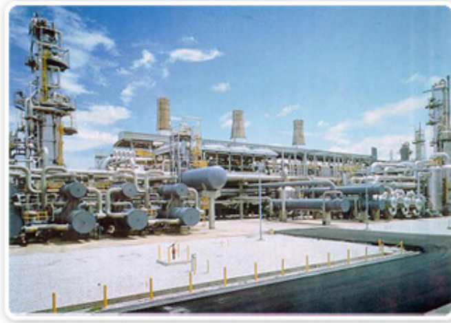
The Arun LNG facility
